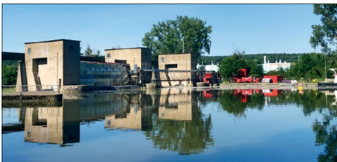
299 Meter lang ist die Staustufe Limbach bei Eltmann, die von den Stahlbauern der Schorisch-Gruppe aus Karstädt saniert wird. Bericht und Foto: Schorisch-Gruppe
